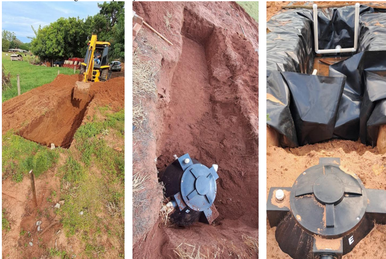
Figura 1 – Implantação do sistema unifamiliar Wetland Construído WC-FSSH
