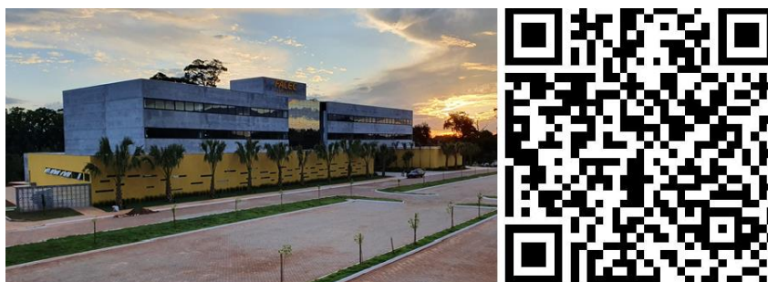
Figura 1. Edificação com três pavimentos em alvenaria, do novo campus da FACEC. Ilustração da visão frontal, após a completa execução do projeto. Rodovia PR 082, km 468, lote 45/46, Gleba Ribeirão, na cidade de Cianorte, Estado do Paraná, CEP: 87200-000.
