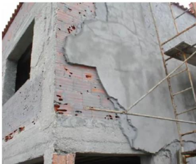
Figura 1 - Desplacamento “Reboco”
