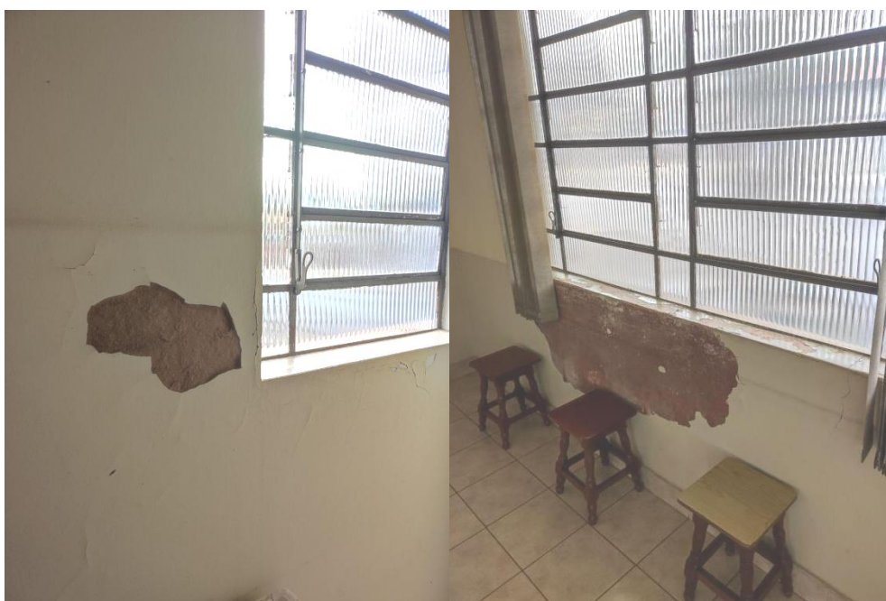
Figura 11 - Interna do lado direito (Nave).
