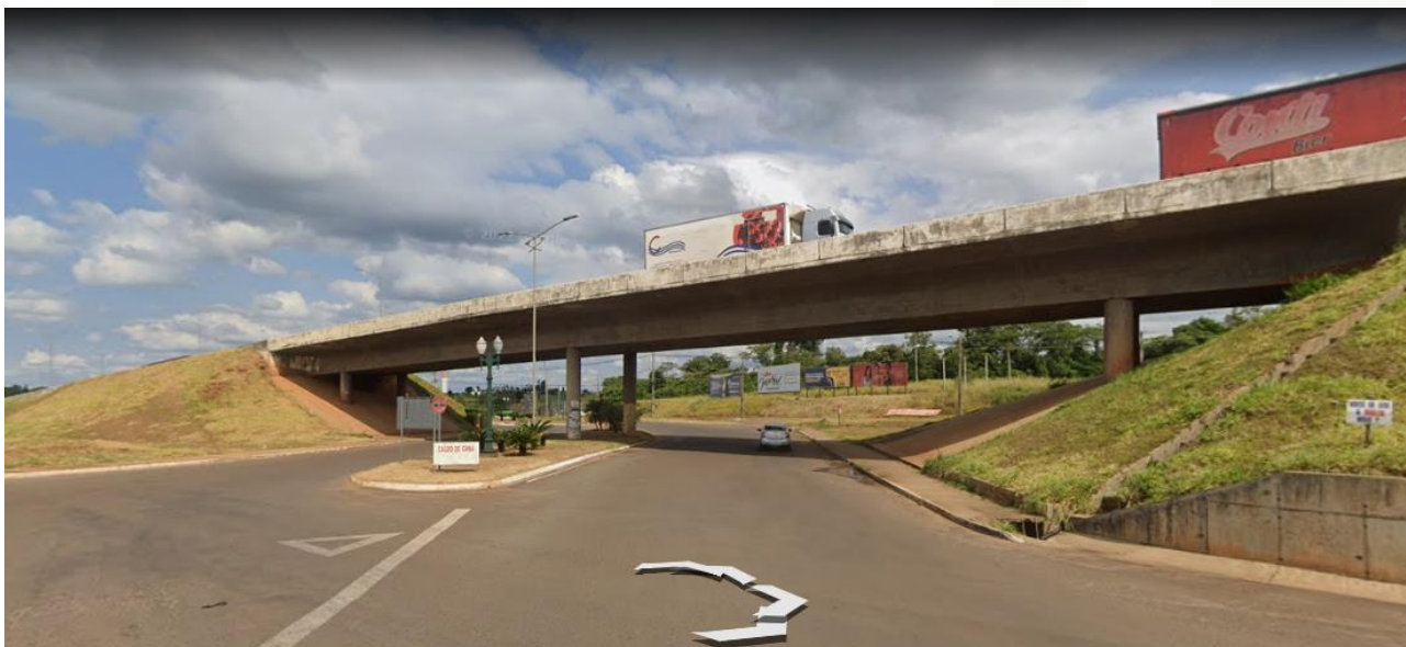
Figura 2 - Viaduto de ligação da Av. Paraíba com as PR – 323 e PR – 082.
