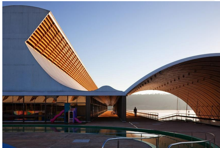
Figura 3 – Área externa do Hospital Sarah, de Salvador.
