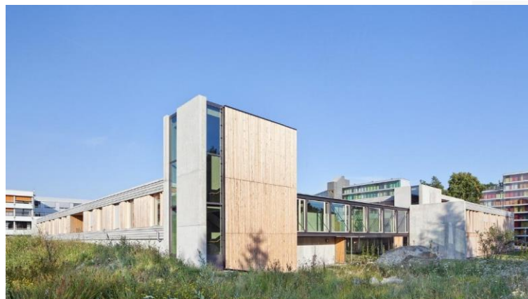
Figura 7 - Parte da fachada externa da clínica Friedrichshafen
