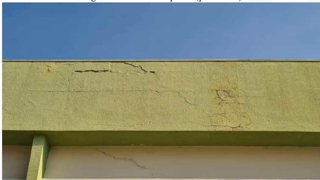
Figura 10 – Fundo da quadra (platibanda)
