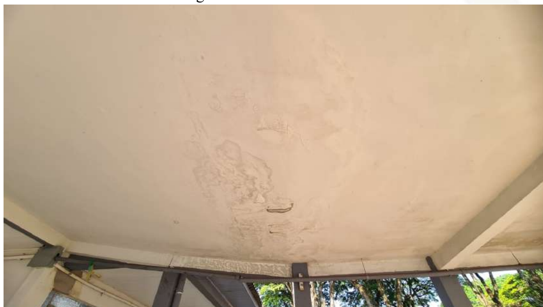
Figura 14 – Teto do corredor
