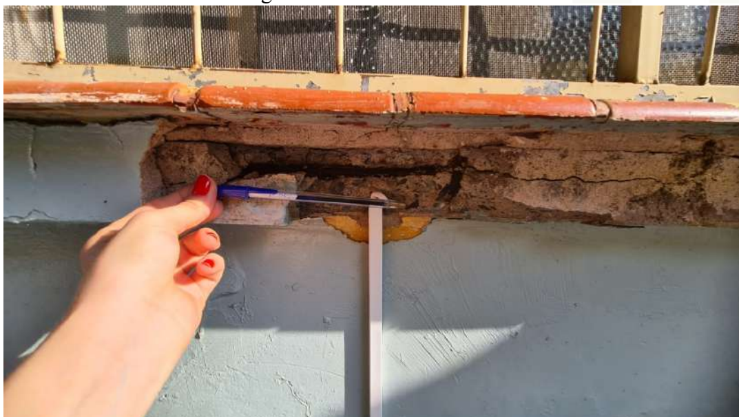
Figura 12 – Fundo da cozinha
