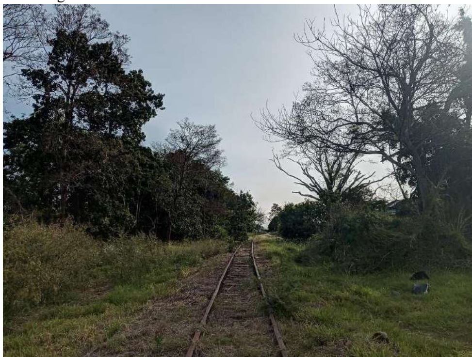
Figura 5 – Trilhos entre a Avenida Maranhão e a Rua Corumbá
