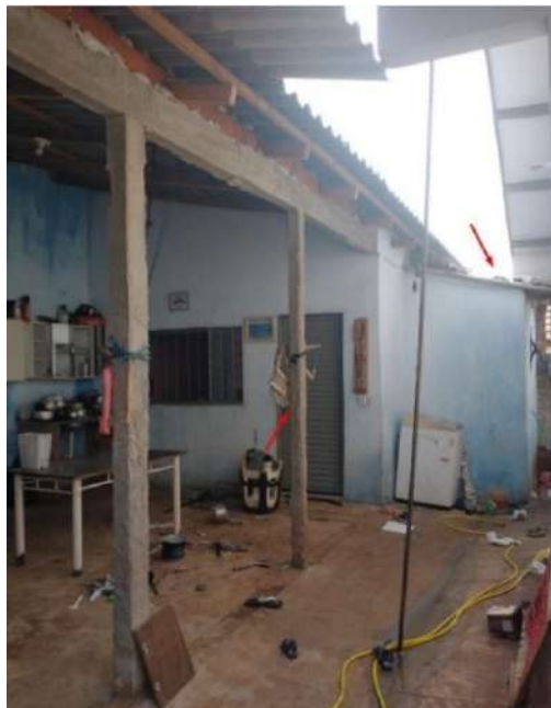
Figura 28 - Ampliação da edícula aos fundos do lote Residencial Recanto Verde fase III
