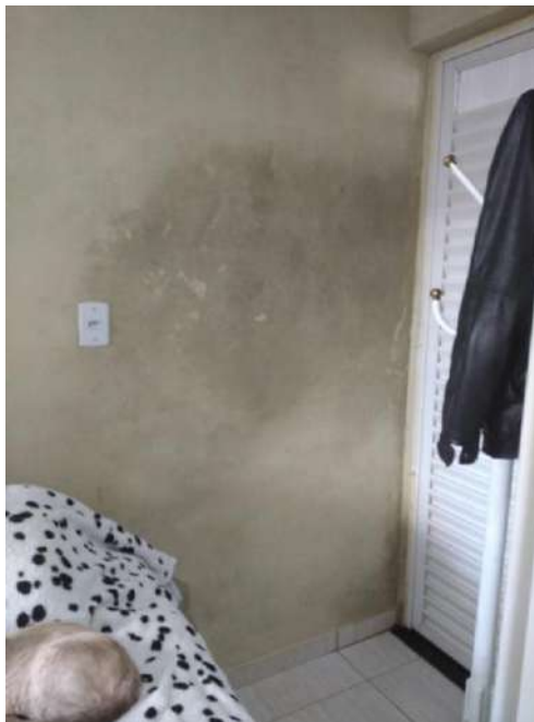
Figura 30 - Ampliação de dormitório Recanto Verde fase III
